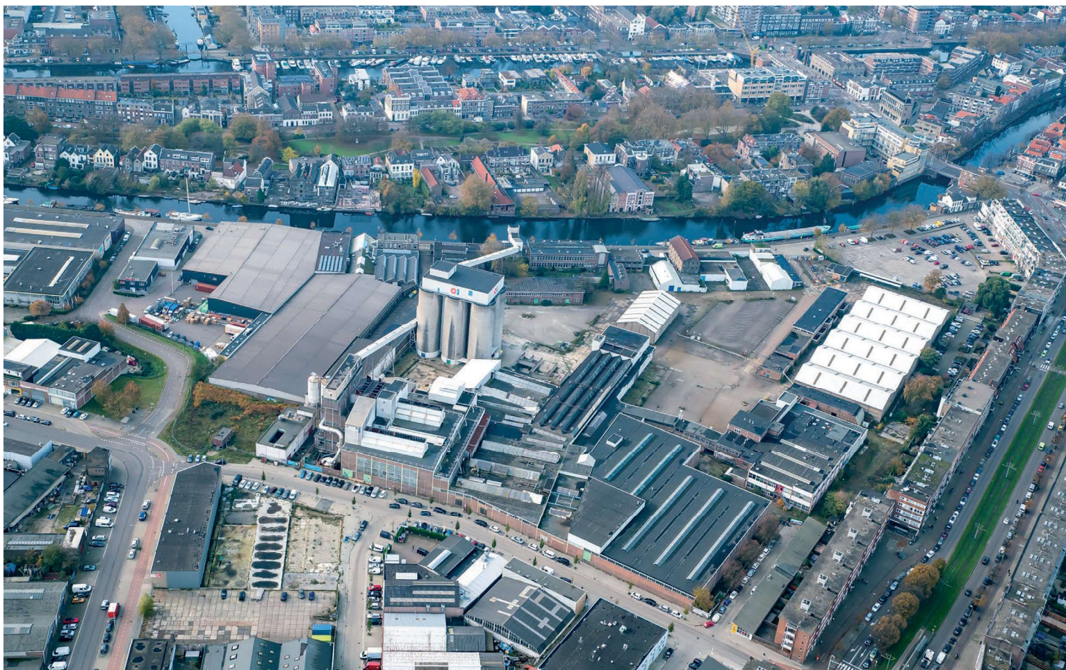
Glasfabriek Schiedam: Wonen, werken en verblijven op een plek met historie
